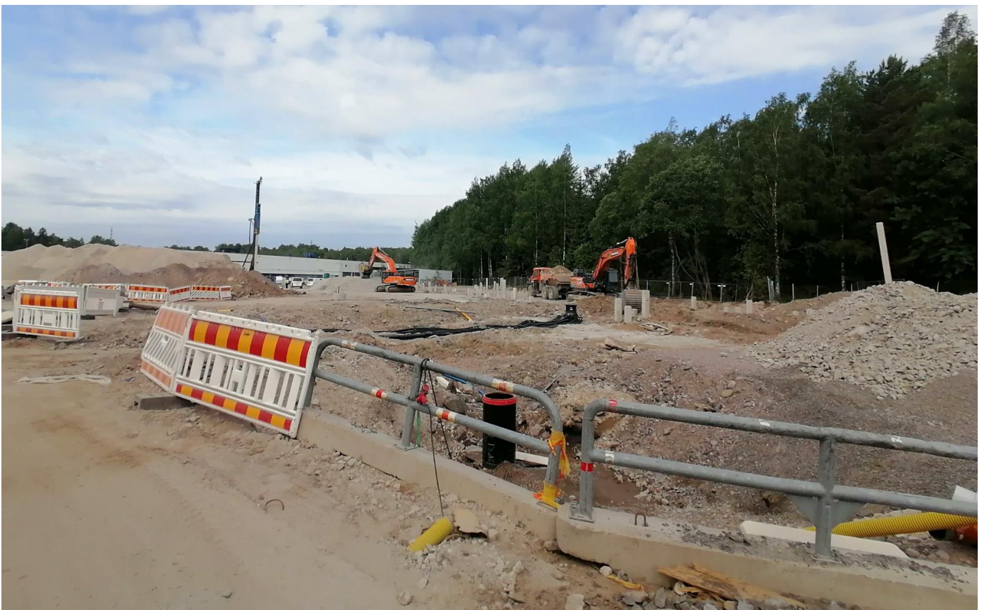
6.6.2024 | Piha-alue, ajoneuvokatoksen paalutus- ja pohjanvahvistustyöt
