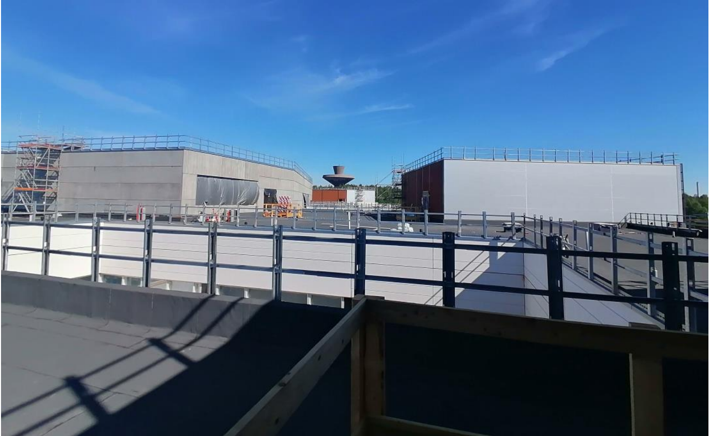
Vesikatto / IVKH – C-lohko
