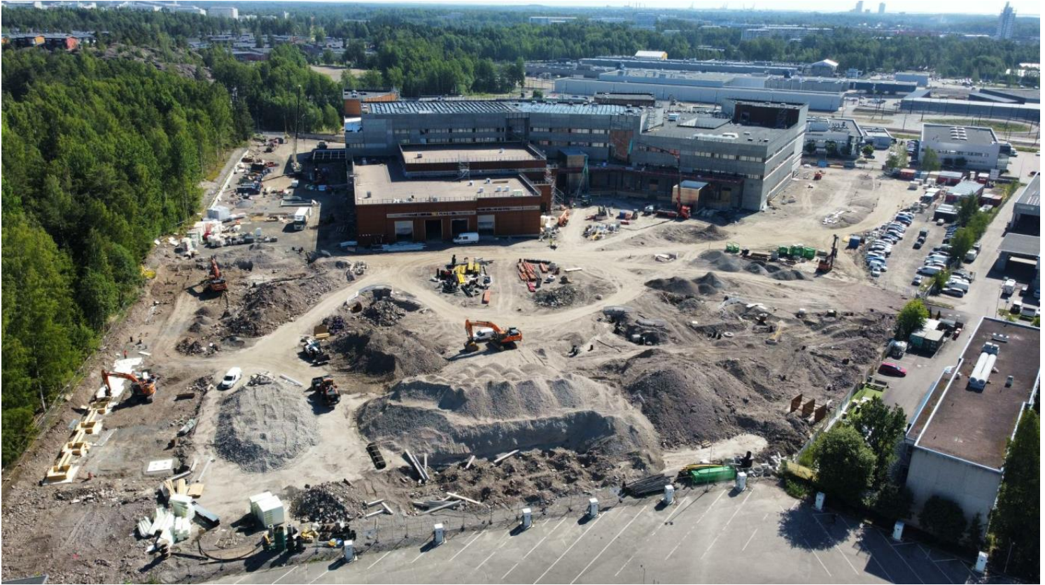
Läntinen julkisivu ja piha-alue Kuvassa vas. alhaalla ajoneuvokatoksen perustustyöt käynnissä
