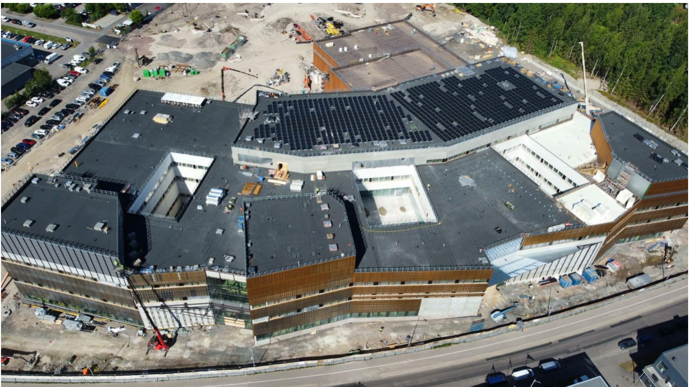
Aurinkosähköjärjestelmän ja -paneelien asennukset katolla
