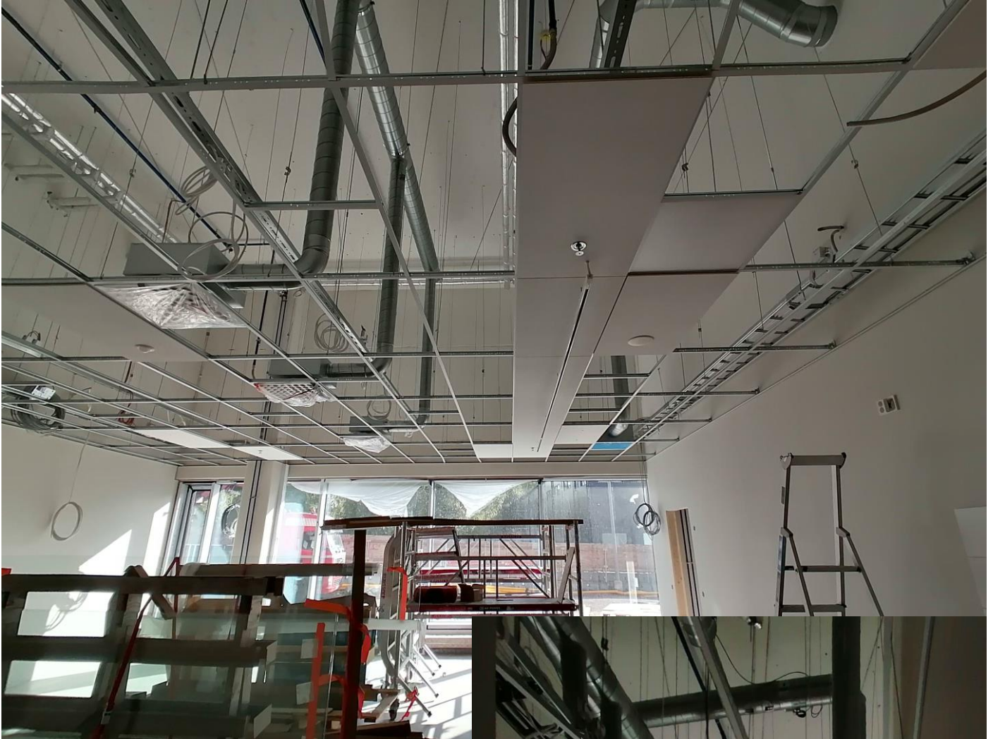
A-lohko 1.kerros | Alakattoasennukset käynnissä
